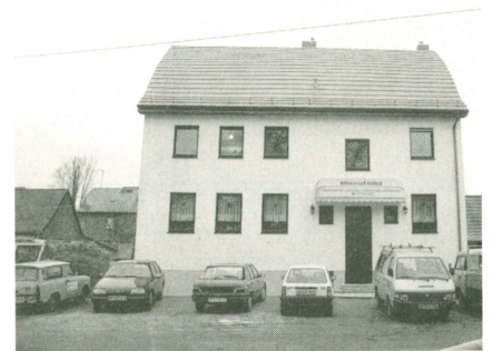
Bild 7: Das fertige Dach.
