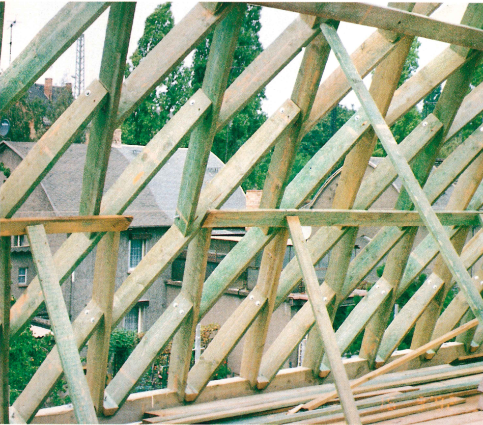
Bild 2: Das Rauten-Lamellen-Dach beim Aufrichten.
